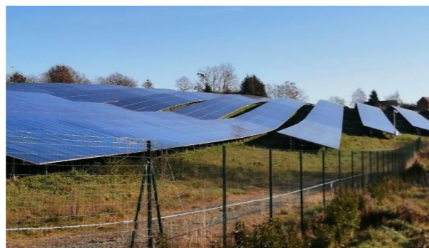
Photographie 5 : Exemple d'installation photovoltaïque au sol (Source : ENCIS Environnement)
